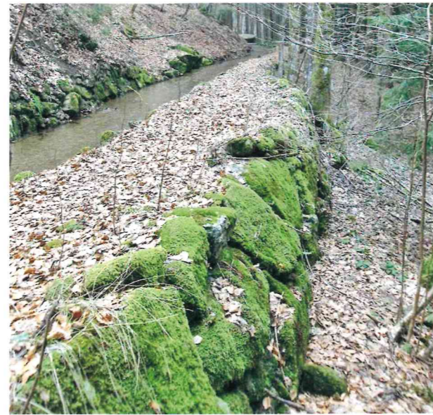
Trockenmauer oberhalb und unterhalb des Wuhres
